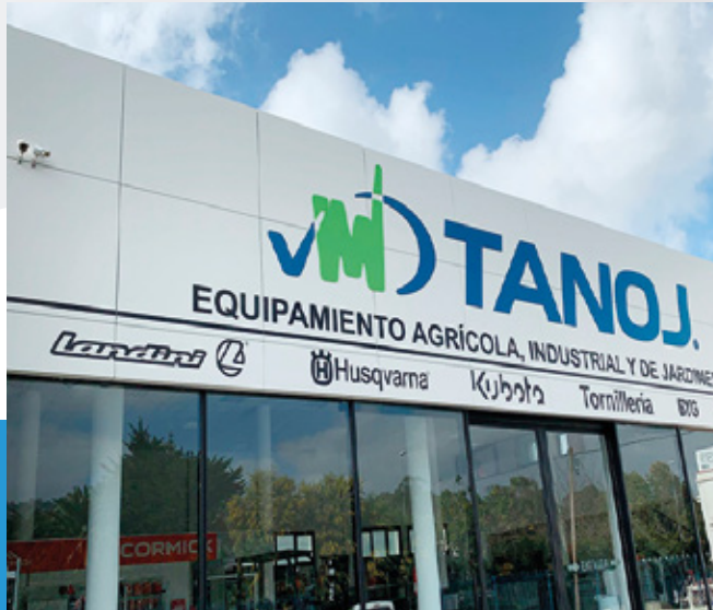
■ Revestimiento de fachada con rotulo torquelado en PVC.
