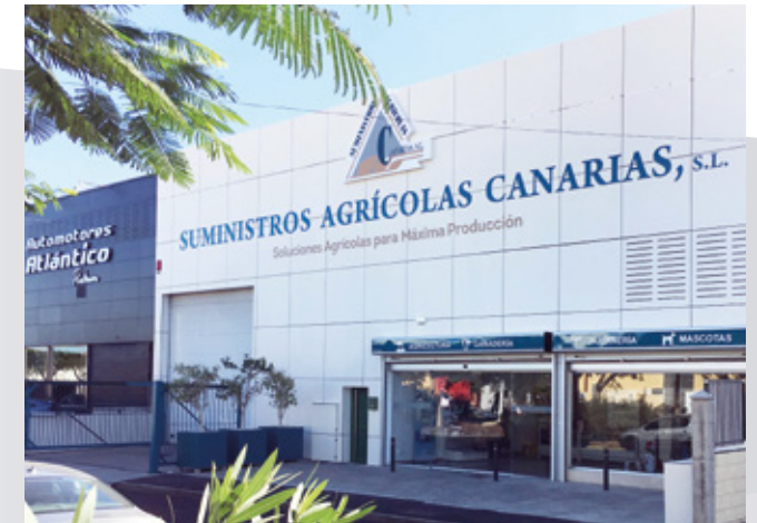
■ Revestimiento exterior de fachada
