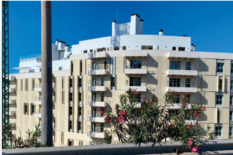
Fachada Ventilada Edificio Guanarteme 104 Viviendas
