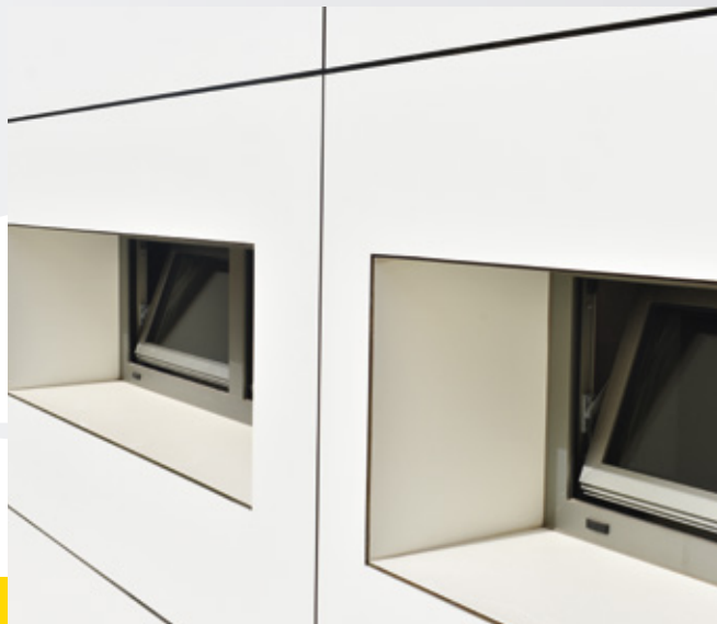
■ Revestimiento exterior de ventanas
