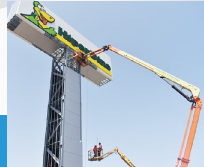
■ Revestimiento de estructuras
