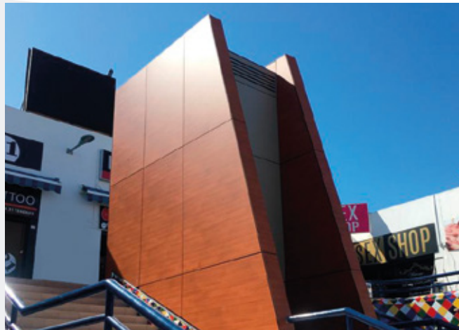
■ Revestimiento exterior de ascensor
