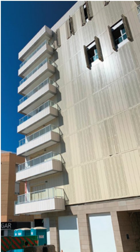
Fachada Ventilada Edificio Guanarteme 104 Viviendas
