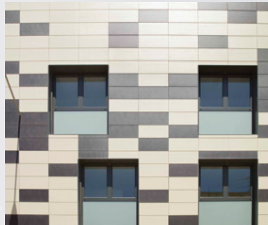
Fachada Ventilada Edificio Guanarteme 104 Viviendas
