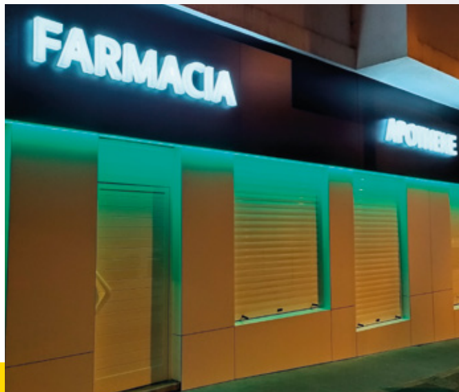
■ Revestimiento exterior con iluminación lineal
